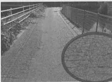
舗装を補修、補強
