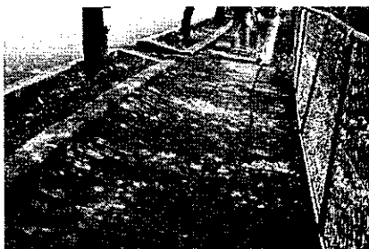
路面のゆがみ・段差
