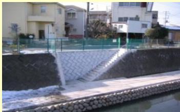
階段通路整備
