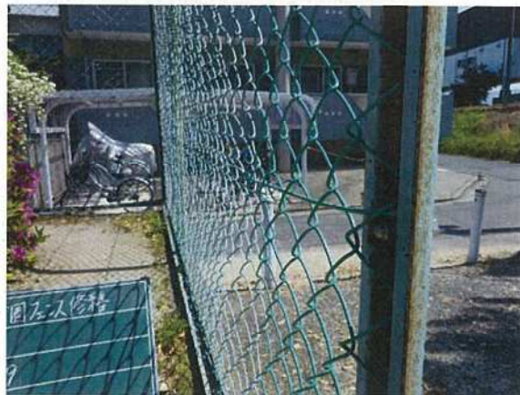
ボルト処置後
