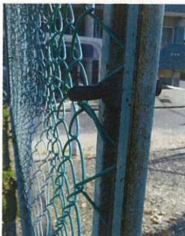
ボルト応急処置状況
