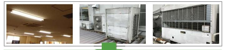
【対策】LED照明、高効率インバータ空調機に更新
