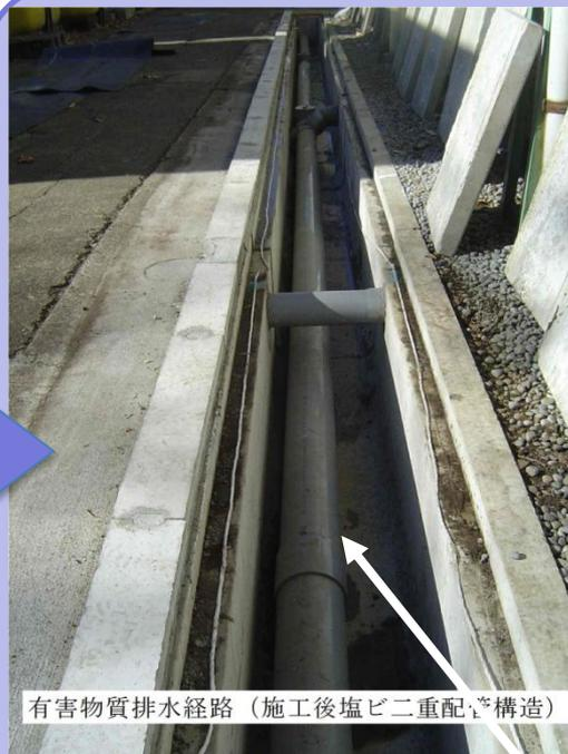
U字溝の内部に塩ビ管を設置し、二重構造とした(目視点検を簡素化)
