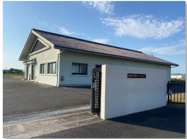
農業集落排水施設
