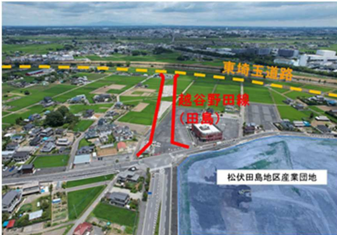
整備実施箇所例 越谷野田線(田島)
