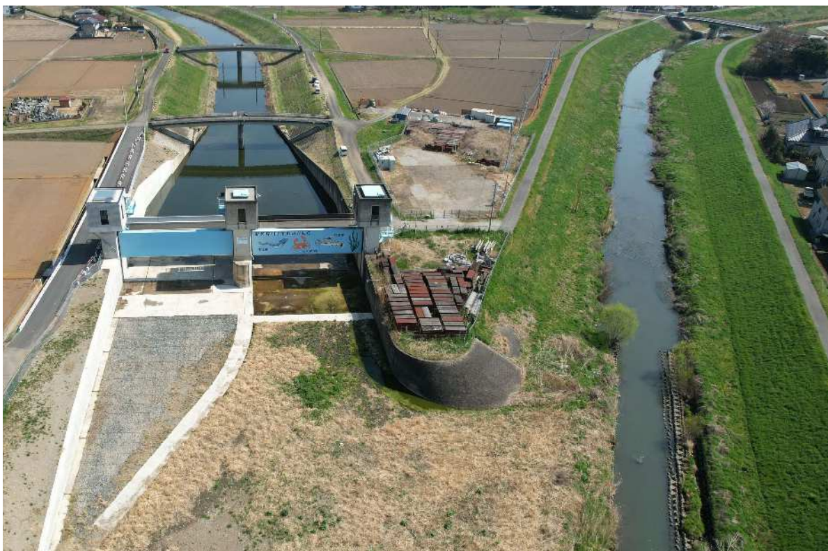
渋井水門 (左) 新河岸川放水路、(右) 新河岸川 (川越市)
