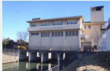
辰井川排水機場 / 辰井川 (草加市)
