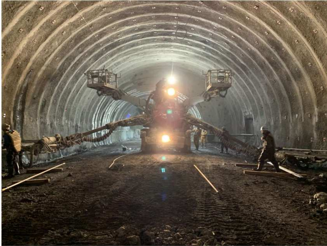
一般国道140号 大滝トンネル工事（秩父市）
