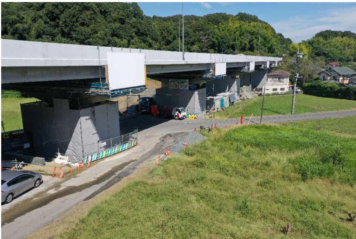
一般国道254号（小川町）
