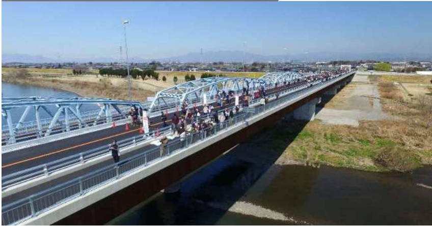
伊勢崎深谷線(上武大橋)
