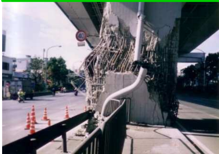
高速道路の橋脚
