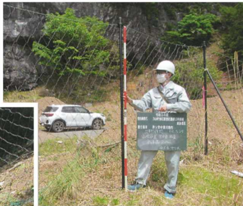
獣害防護柵の設置状況の確認
