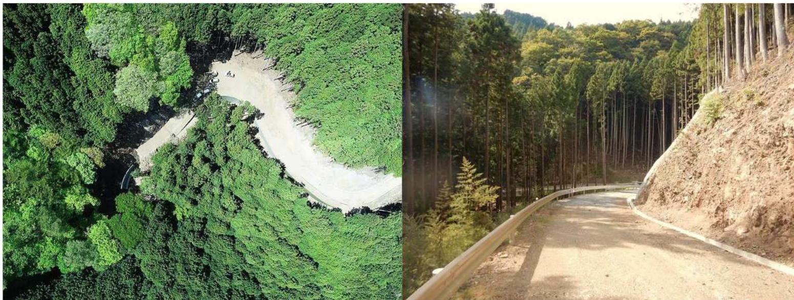
開設中の森林管理道
