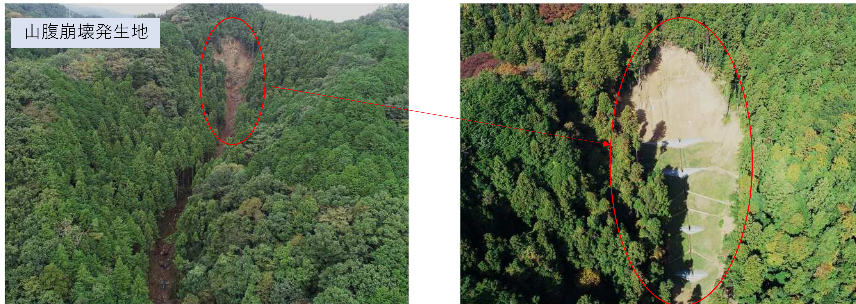
治山の災害現場（左：復旧前 右：復旧後）
