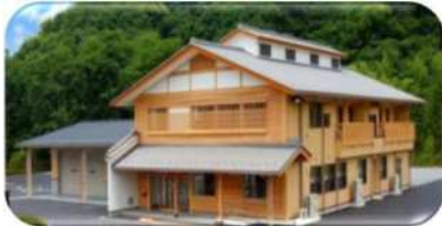
秩父消防北分署（皆野町）木材使用量 124㎡
