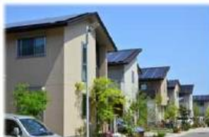
再生可能エネルギーによる暮らし
