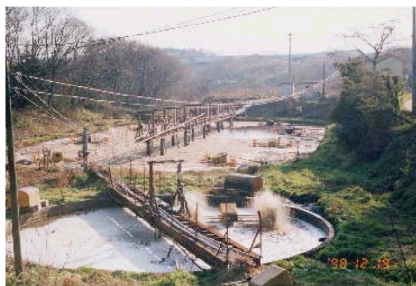
図18 表面曝気式ラグーンの実プラントの様子 (下:原水槽、上:反応槽)
