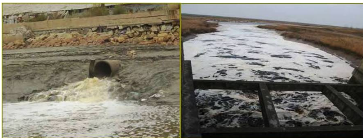
写真-1 2007年海域に排出する汚染物質排出口の様子
