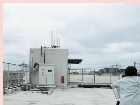
PCB廃棄物立入検査
