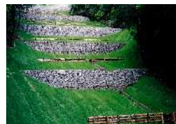
治山施設の整備
