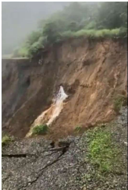
火山灰質の土の崩壊
