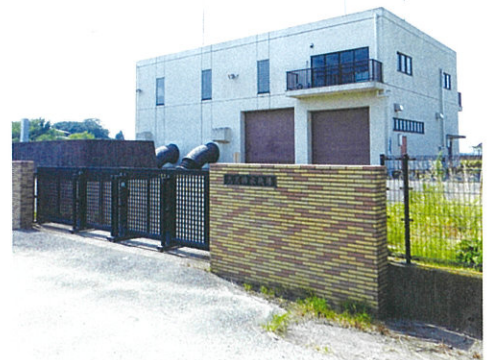
▲九尺排水機場外観
