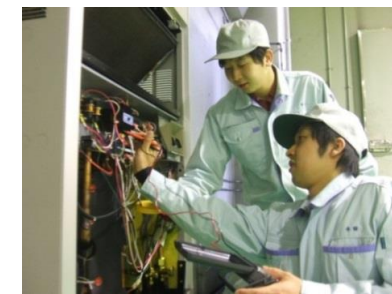
（業務用エアコン点検の実習）
