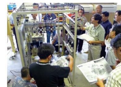
（電気設備の実習）
