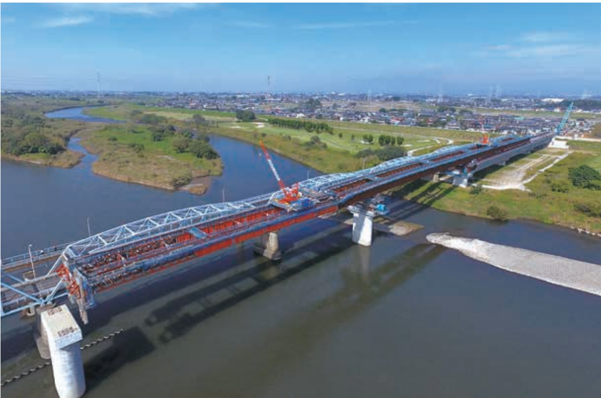
老朽化した橋りょうの架換え(上武大橋)
