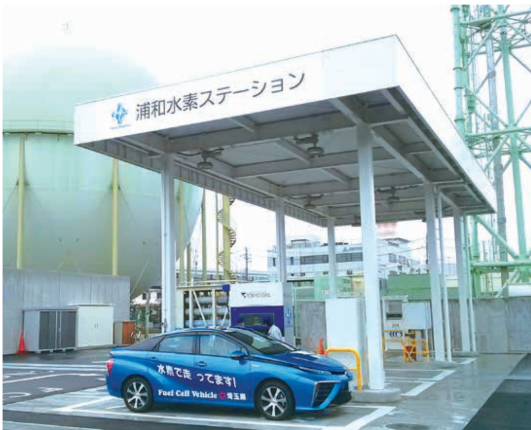
水素ステーションと燃料電池自動車
