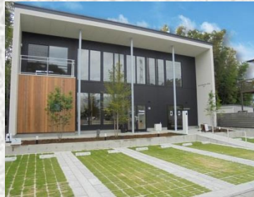
駐車場の緑化(鶴ヶ島市)
