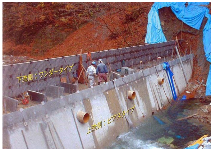
写真Ⅲ- 4-2 残存型枠工法の施工状況
