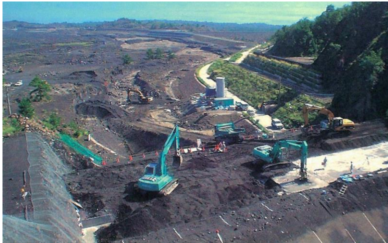
写真Ⅲ- 4-3 ISM 工法による施工状況全景
