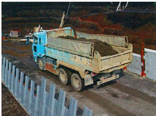
写真Ⅲ- 4-6 内部材の運搬状況
