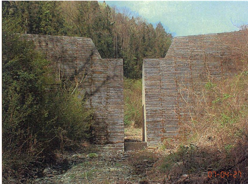
写真Ⅲ- 4-8 間伐材による砂防堰堤の修景
