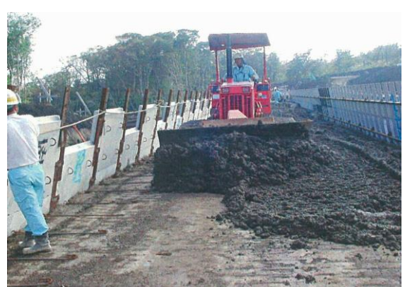
写真Ⅲ- 4-7 ブルドーザによる内部材の敷均し
