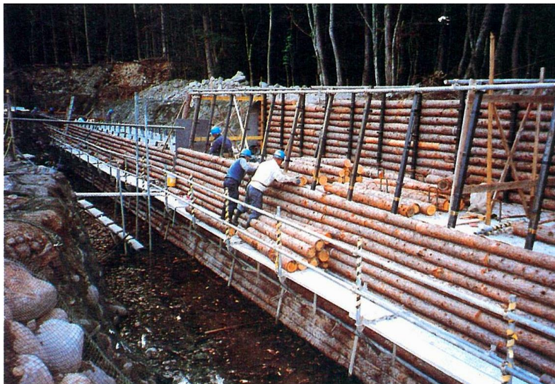
写真Ⅲ- 4-9 間伐材の施工状況
