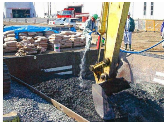
写真Ⅲ- 4-5 混合枘への加水状況
