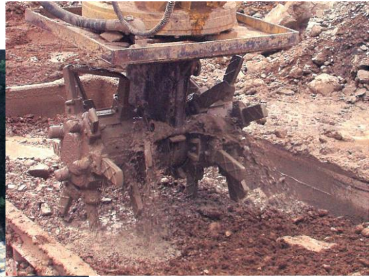
ツインヘッドによる攪拌混合
