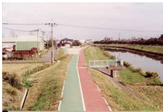
綾瀬川の遊歩道の整備（越谷市）
