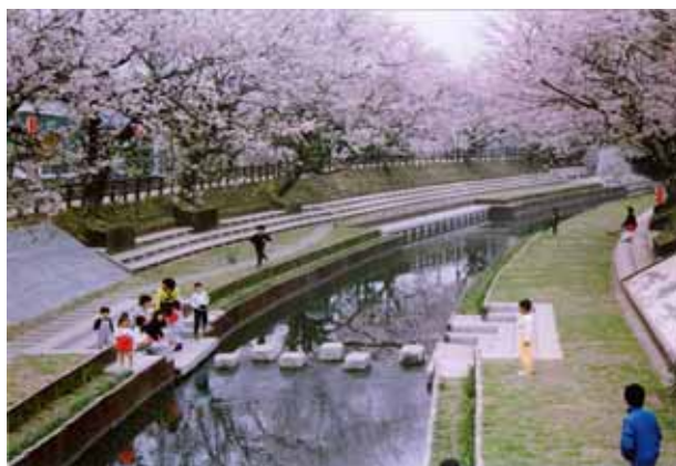
元荒川の親水護岸の整備（吹上町）
