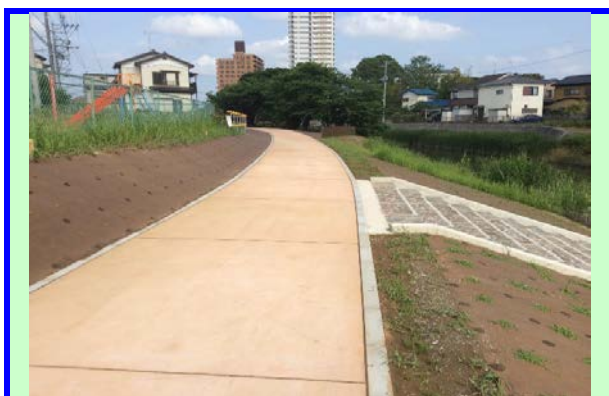
総簡加) 河川改修工事(親水護岸工)(古隅田川)
