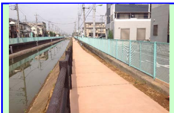
葛西用水親水化護岸(第5期)工事
