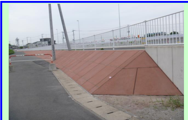
道路改築工事（法面保護工）
