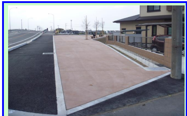
南古谷駅前通り街路整備工事
