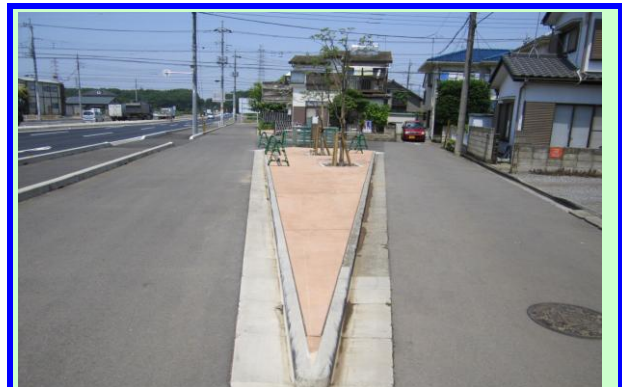
地方特定道路（改築）整備工事
