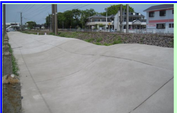
JR東日本防草工事
