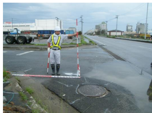
仙台港復旧査定業務
