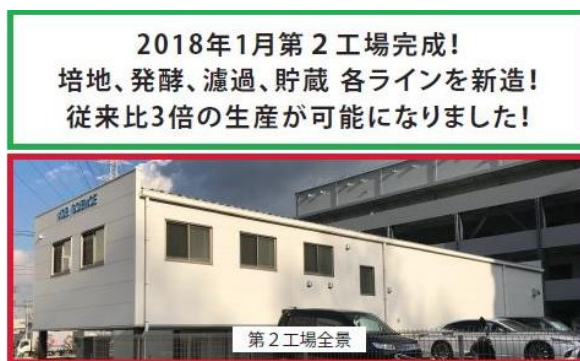
平成 3 0 年より稼働開始した第 2 工場
