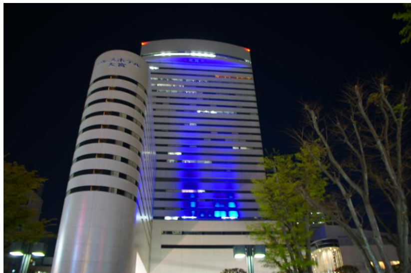
大宮ソニックシティビル（さいたま市） （平成30年4月8日（日）実施）
